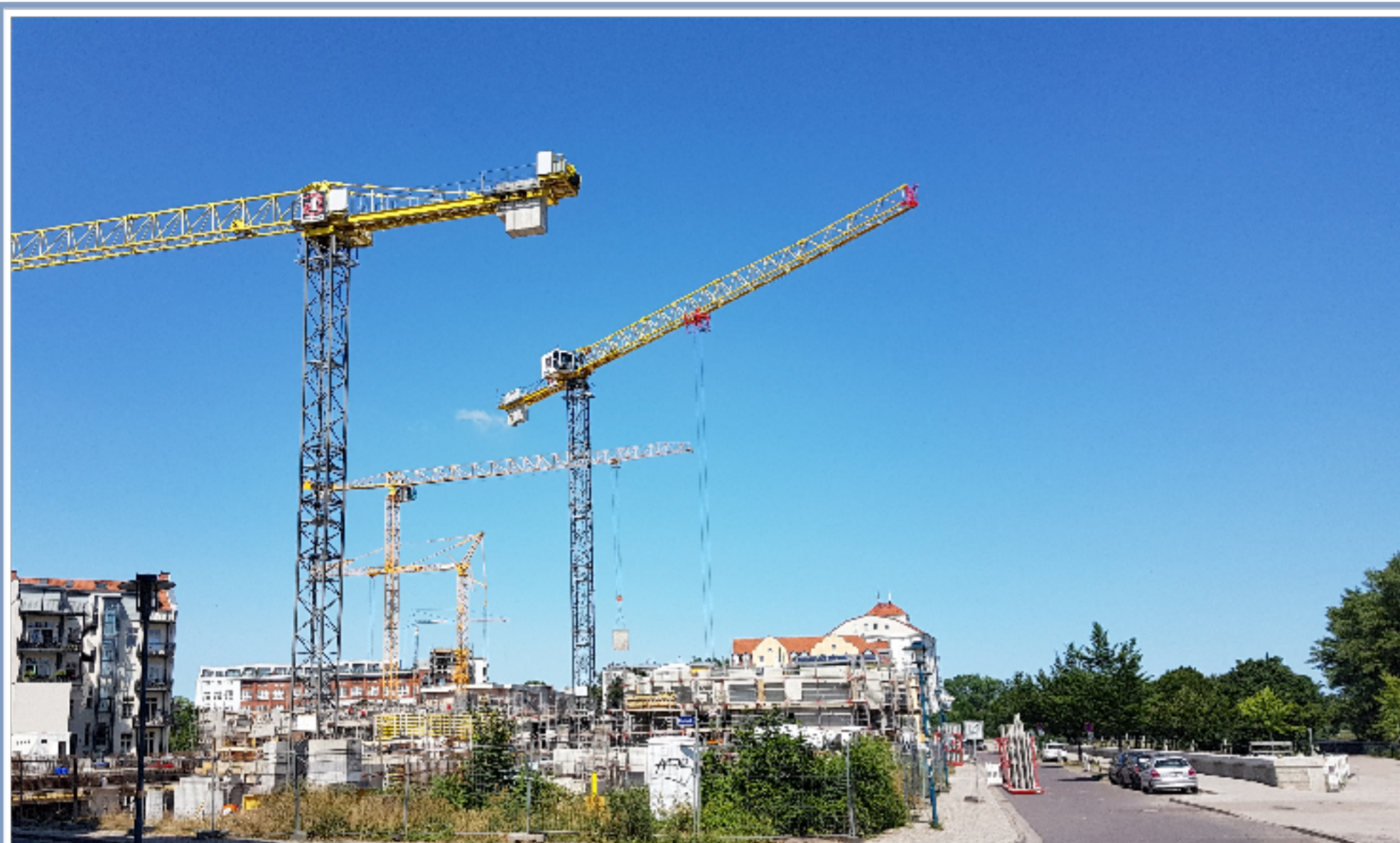
Straßensperrungen und Baulärm: Die Baustelle des "Quartiers an der Elbe"
