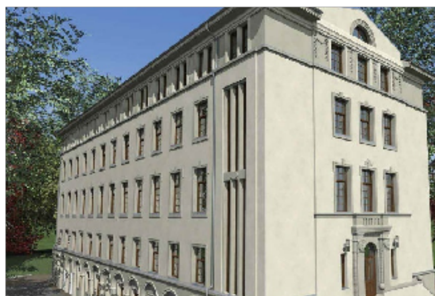
Das ehemalige Bahnverwaltungsgebäude am Editharing
